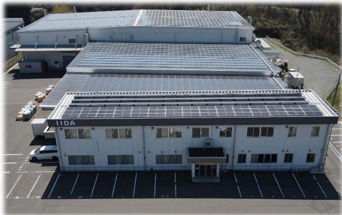
福島第2工場 太陽光発電システム（自家消費）375.6kw（2023年8月 20kw増設）
